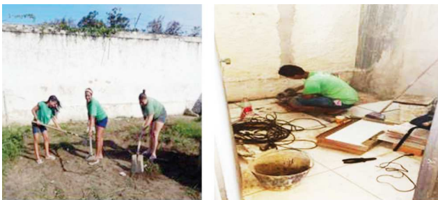
Figura 19 – Manutenção de Capina e Colocação de piso.
