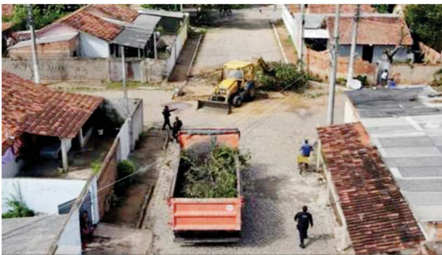
Figura 2 – Desobstrução das ruas.
